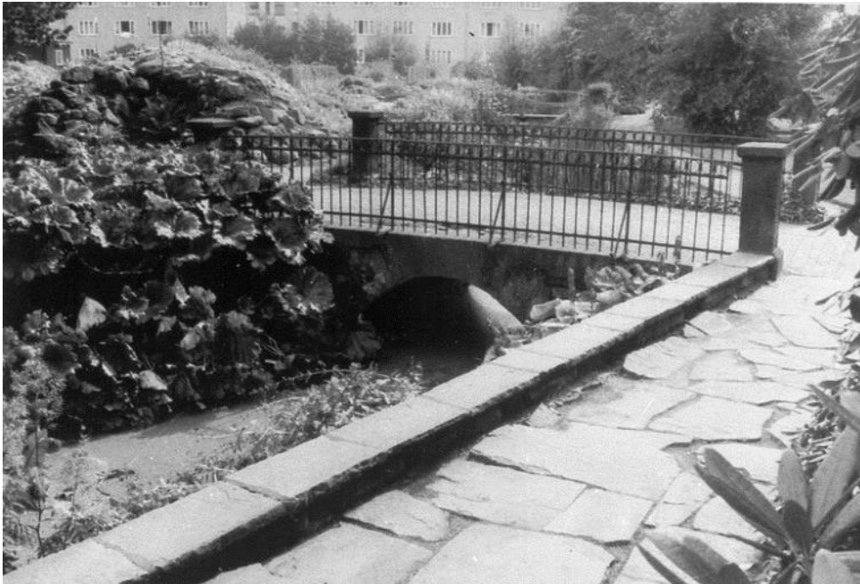
Abb. 76 Steinbrücke über den Teich, links Blick auf das Alpinum und im Hintergrund der Bachlauf, vermutlich 1950/60er Jahre, Bildarchiv Foto Marburg mi12626d07
