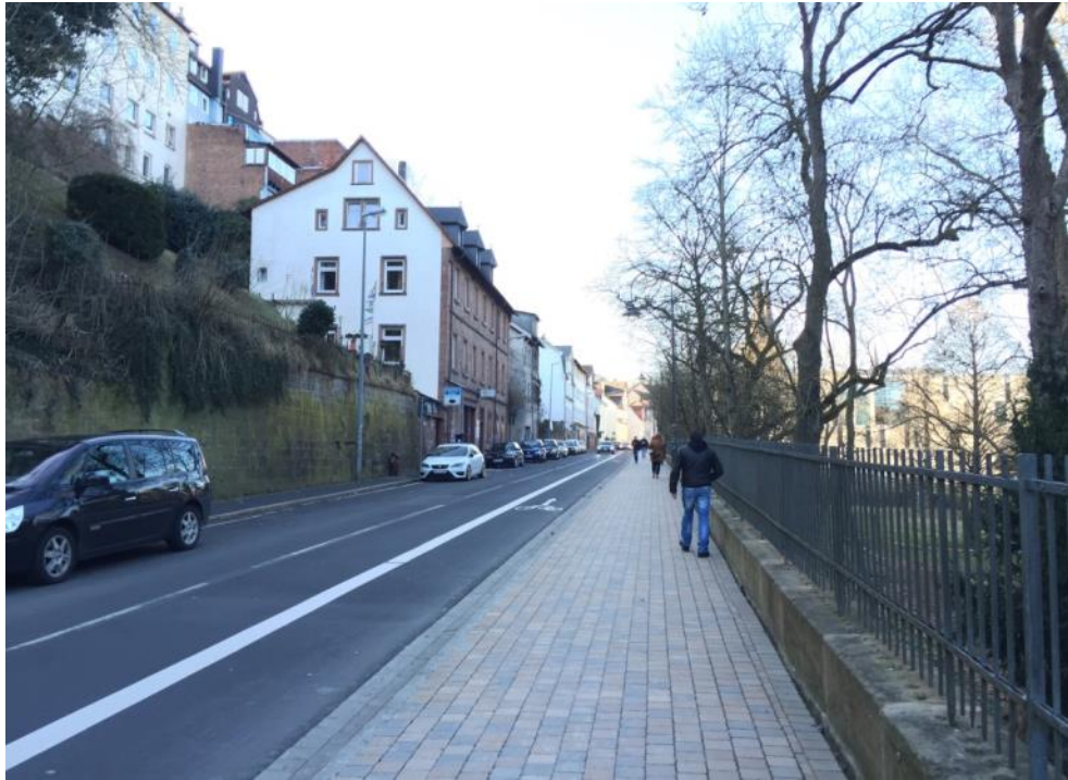
Abb. 74 Am Pilgrimstein, sanierte Mauer und neuer Gehweg, Foto SHK
