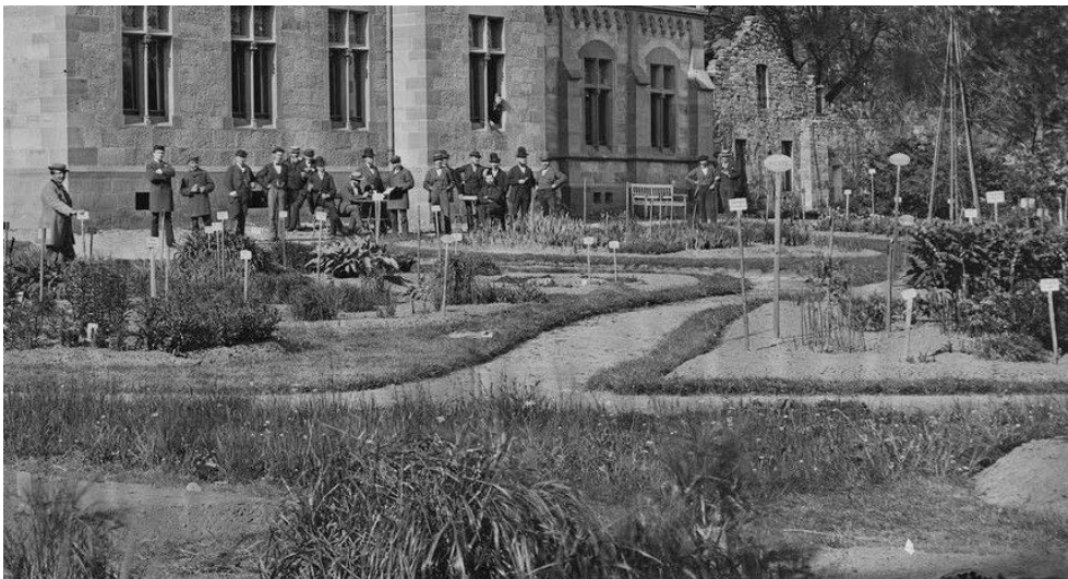
Abb. 58 Pflanzbeete vor dem neuen Institutsgebäude mit Sandwegen, Einfassung der Beete mit Rasenbändern, Bildarchiv Foto Marburg, fm810479
