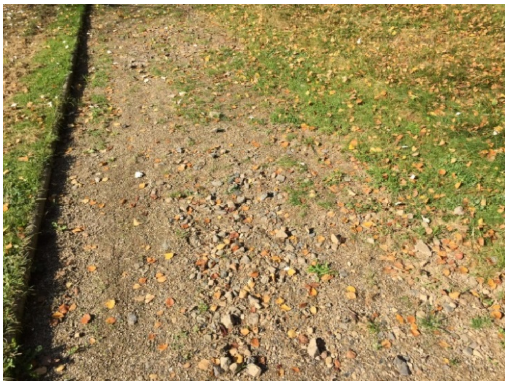
Abb. 55 Wegezustand mit Erosion und Bewuchs, Foto SHK
