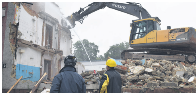
In der Gerhart-Hauptmann-Straße entstehen 18 moderne Wohnungen mit jeweils 63 Quadratmetern.
