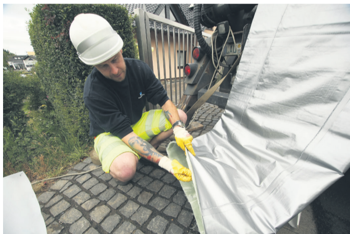
Polier Moritz Broshog zeigt den Inliner aus Glasfaser.
