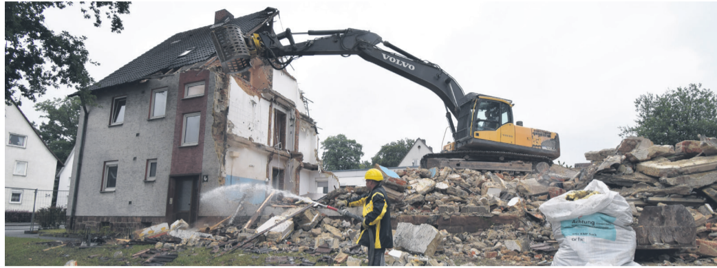
Das nicht mehr zu sanierende Mehrfamilienhaus in der Gerhart-Hauptmann-Straße verschwindet für einen Neubau. Fotos: Michael Rinde
