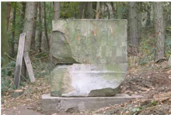
Abb. 9: Der beschädigte Meridianstein nach seiner Wiederaufstellung im September 2009.
