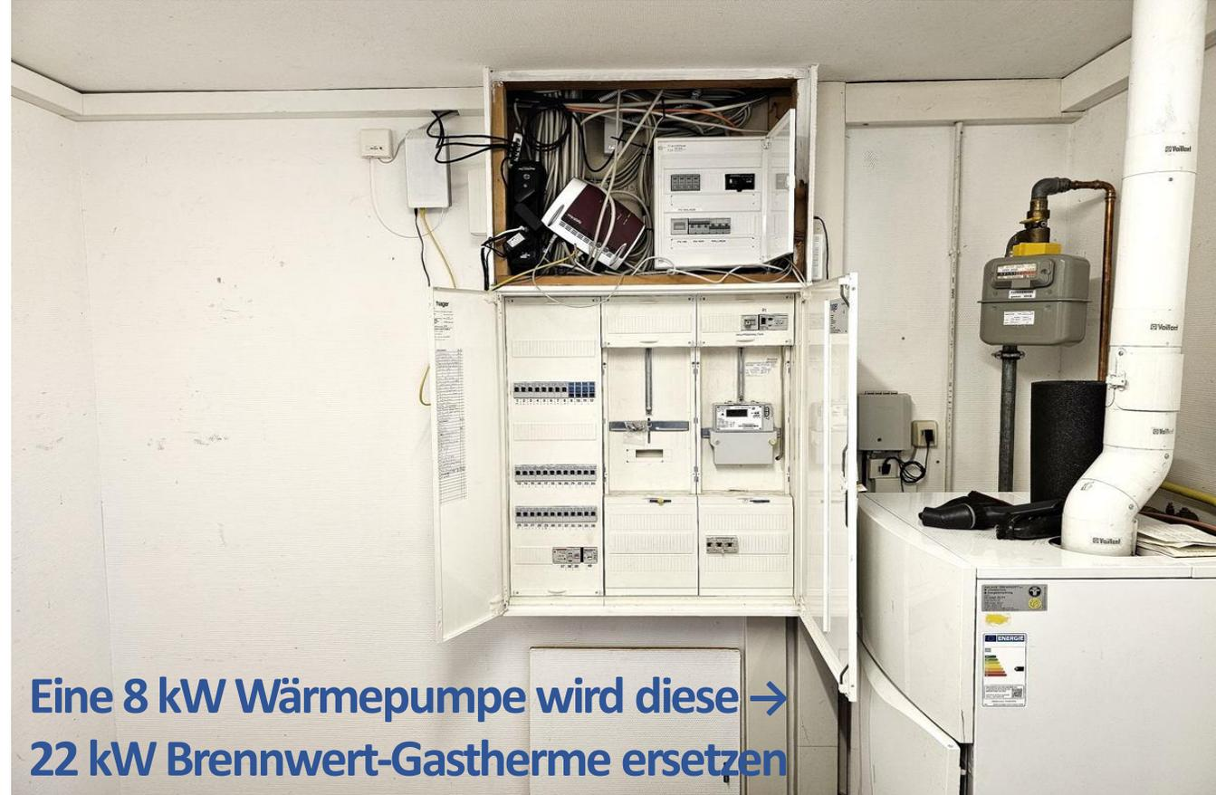
Eine 8 kW Wärmepumpe wird diese →
