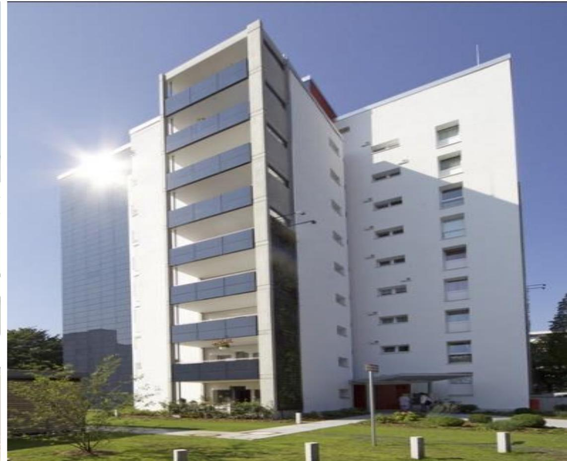
Vorgehängte hinterlüftete oder gedämmte **CIGS**-PV-Module (**C**upfer**I**ndium**G**allium**S**ulfid).
