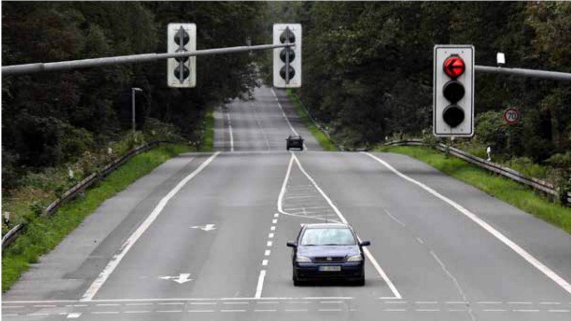
Abb. 8: Bergsenkungsmulde entlang der Münsterstraße in Gelsenkirchen. Im Vergleich zum Jahr 1892 hat sich das ursprünglich ebene Gelände um mindestens 19 m abgesenkt (eigene Aufnahme)
