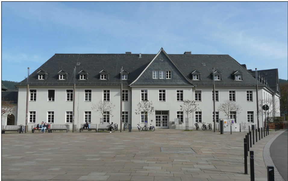
Abb. 3 Im Carolinenhaus (Deutschausstraße 12, ehemalige Kinderklinik) sind heute u. a. einige Arbeitsgruppen des FB Geographie untergebracht (Foto: © C. Mann)
