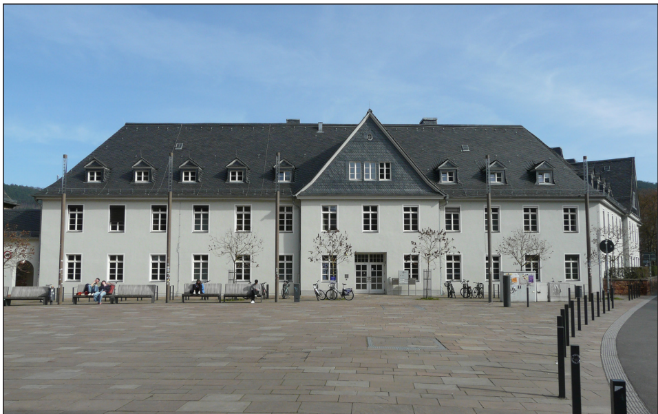
Abb. 3 Im Carolinenhaus (Deutschhausstraße 12, ehemalige Kinderklinik) sind heute u. a. einige Arbeitsgruppen des FB Geographie untergebracht (Foto: © C. Mann)
