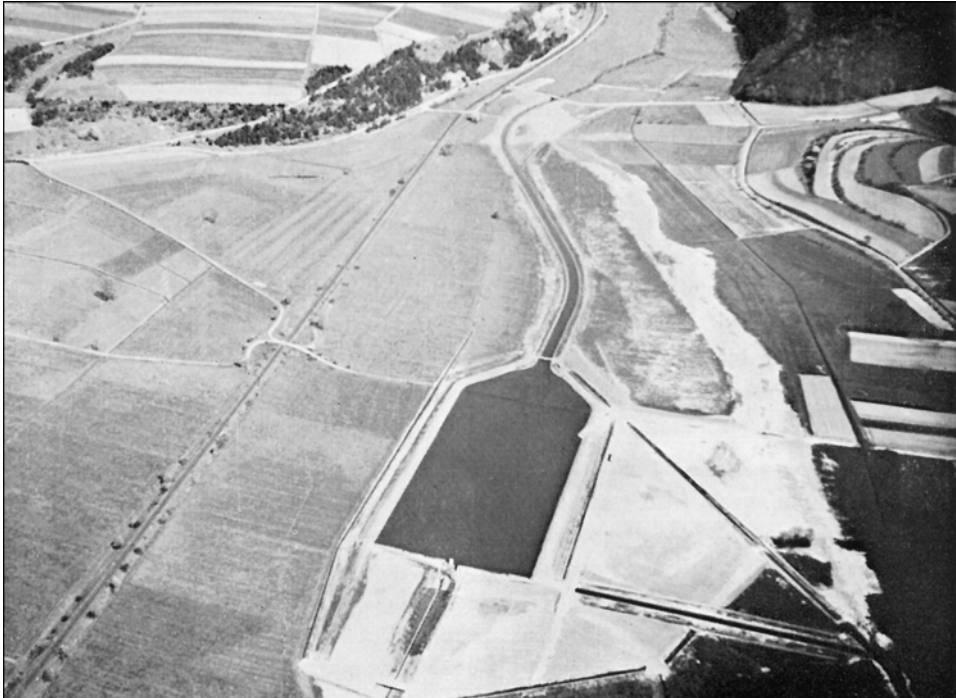
Abb. 1: Luftbild des Sandfanges nach seiner Fertigstellung
