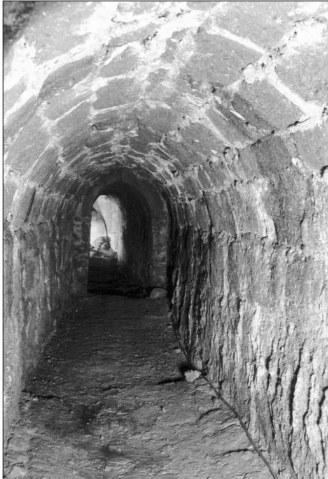
Abb. 1: Der Stollengang des Domkapitels in Exeter
