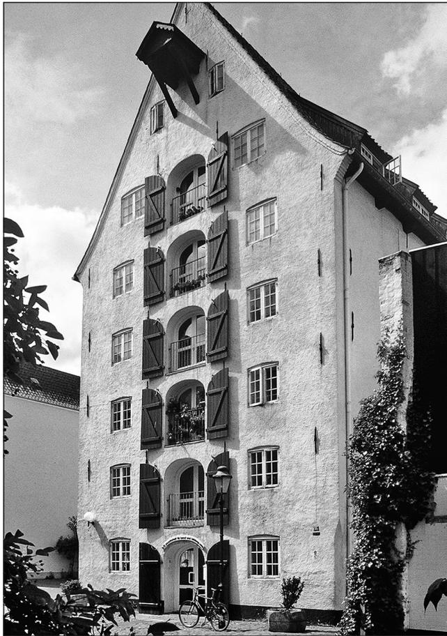
Stellte einst mit seinen Lukentüren und seinem Windenausleger den Prototyp des Flensburger Speichers dar; heute saniert und zu Büro- und Wohnzwecken genutzt. Quelle: GLÜSING 2009, S. 61
