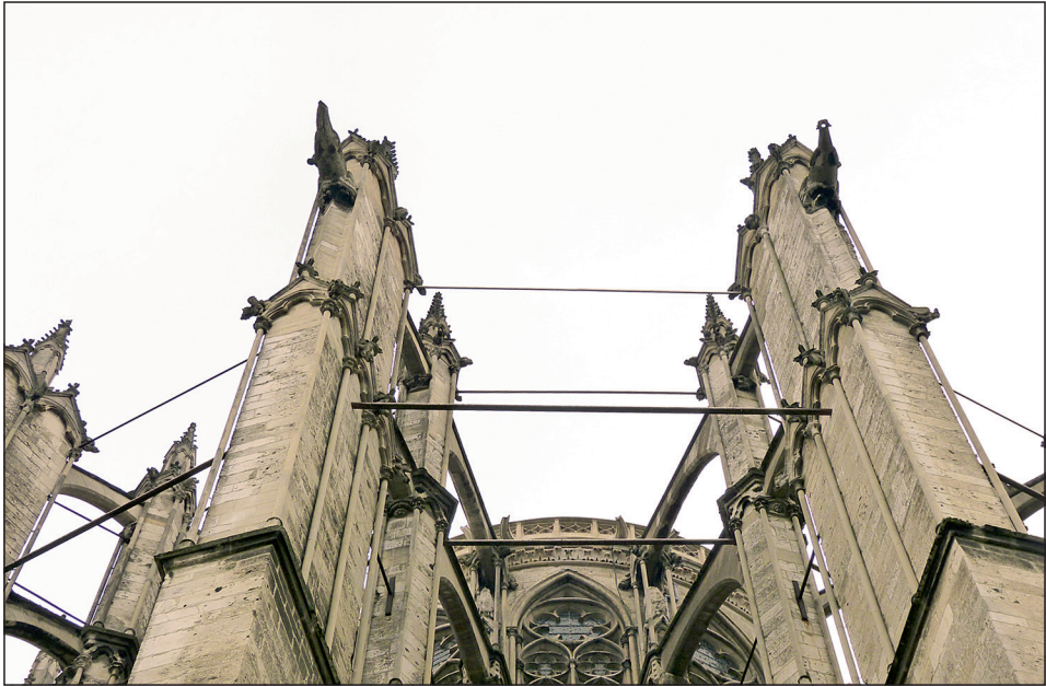
Abb. 5: Bauliche Sicherungsmaßnahmen an der Kathedrale von Beauvais (Foto: H. Dany)
