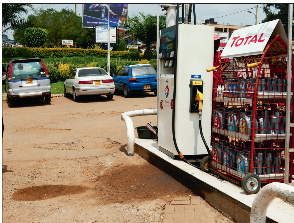
Abb. 7: Tankstelle ohne flüssigkeitsabgedichteten Untergrund führt zu Schadstoffeintrag von Mineralölkohlenwasserstoffen in Boden und Grundwasser (Foto: B. Steinweg, Uganda 2015)
