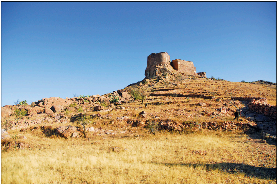
Abb. 9: In vielen Fällen dominieren die Agadire (Getreidespeicherburgen) die Landschaft wie Festungsanlagen, so wie hier der besonders bedeutende Agadir Tasguent
