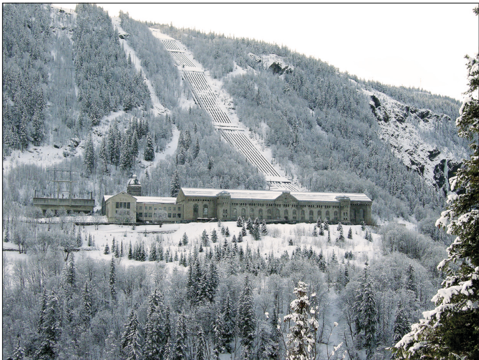
Abb. 7: Das Norsk Hydro Wasserkraftwerk Vemork wurde im Zweiten Weltkrieg Schauplatz einer kriegsentscheidenden Sabotageaktion
