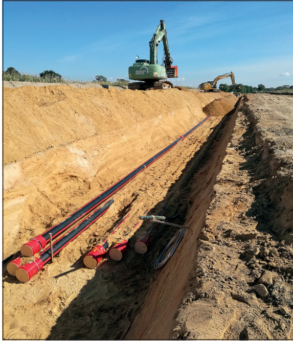
Abb. 4: Bau und Verlegen von Kabeltrassen (Foto: G. Wessolek)
