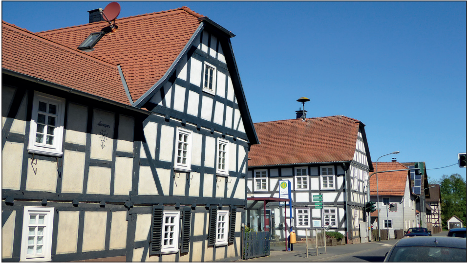
Abb. 6: Einige Häuser in Todtenhausen sind noch im ursprünglichen Stil erhalten (Foto: K. Krantz)
