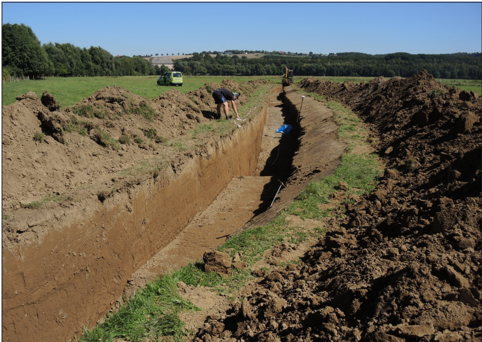
Abb. 3: Baggerschnitt im Füchtener Ruhrboden (Foto: © T. Kasielke)
