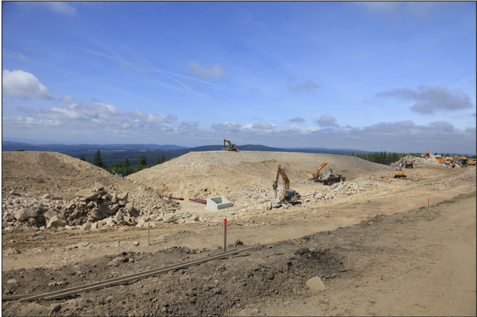
Abb. 6: Baustelle des Speicherbeckens (Fassungsvermögen von 80.000 m 3 , nach REINBOTH 2019) am Wurmberg, Harz, mit einem Verlust des Sichthorizonts (2013) (Foto: © S. Richter)
