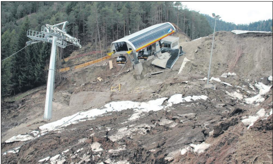
Abb. 7: Eine Rutschung im Cianross Skigebiet, Kronplatz, Dolomiten, Italien (April 2006), ausgelöst durch eine defekte Wasserleitung für die künstliche Beschneigung (Foto: © www.funiforum.org, gemeinfrei)
