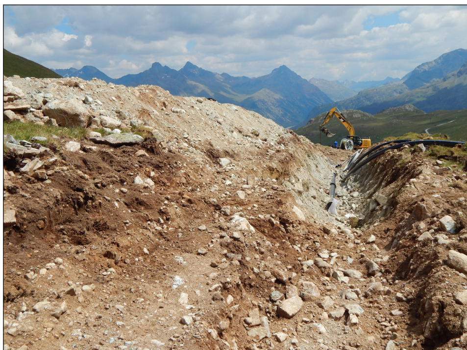
Abb. 9: Zwei Meter tiefer Aushub für eine Kunstschneeleitung, die sich von 2.455 auf 2.825 m erstreckt (Corviglia, St. Moritz, Schweiz), Juli 2018 (Foto: © de Jong)
