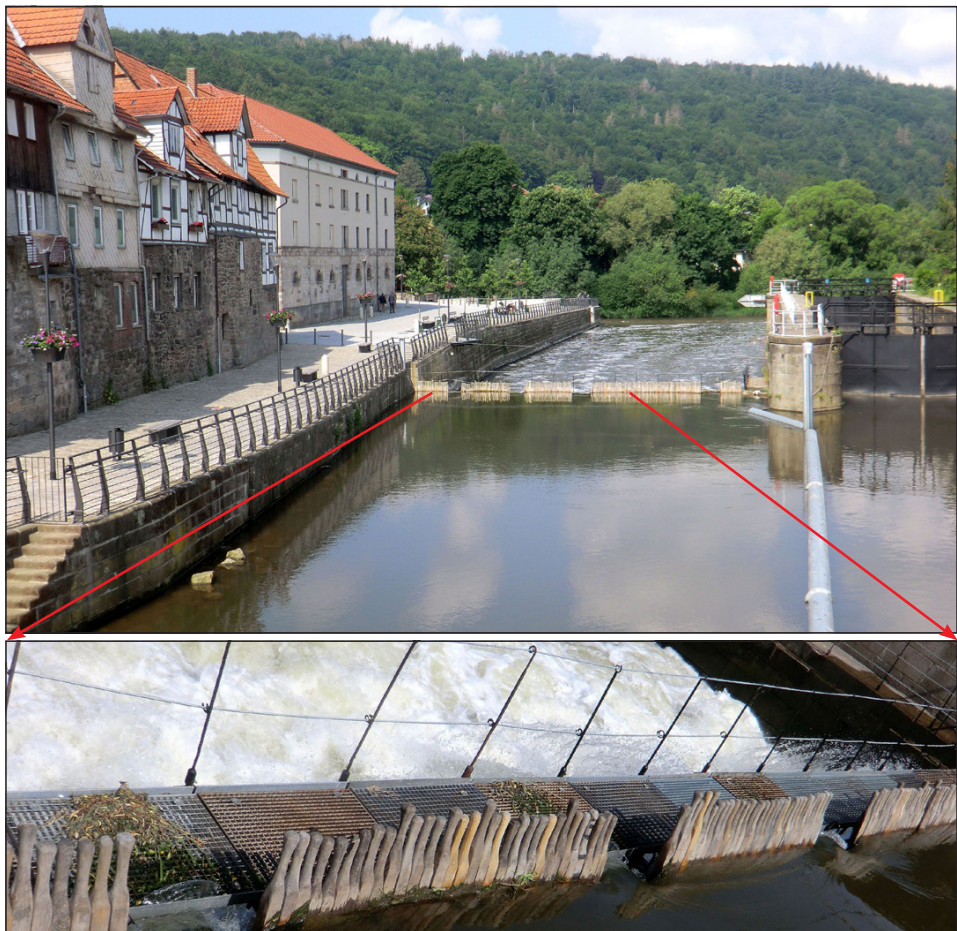
Abb. 15: Das 2015 restaurierte Nadelwehr an der Werrastaufe in Hann. Münden. Oben: Gesamtansicht des Wehrs einschl. der Schleuse. Unten: Anordnung der Nadeln . Der Abfluss wird durch Wegnehmen oder Hinzufügen einzelner Nadeln reguliert. (Quelle: © Museum Fuldaschifffahrt Kassel, autorisiert)
