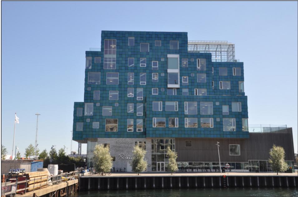
Abb. 2: Neubau der Copenhagen International School (CIS) in Kopenhagen mit integriertem Solarzellensystem in der Fassadengestaltung (Foto: © V. Stelzer)
