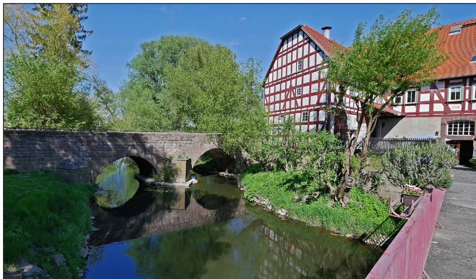
Abb. 19: Die Brücker Mühle und die historische Brücke über die Ohm (Foto: © K. Krantz)
