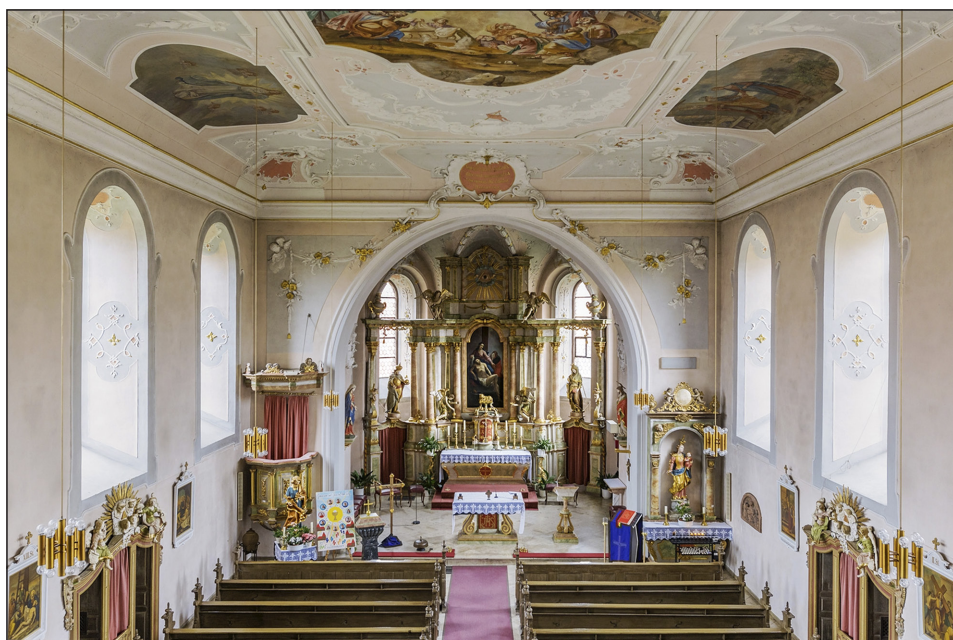
Abb. 9: Innenansicht der Kirche in Roßdorf vor der Renovierung 2022 (Foto: © Th. Hankel, autorisiert; https://www.fotocommunity.de/photo/kleines-barockes-kleinod-in-amoenebur-thomas-hankel/42223338 )
