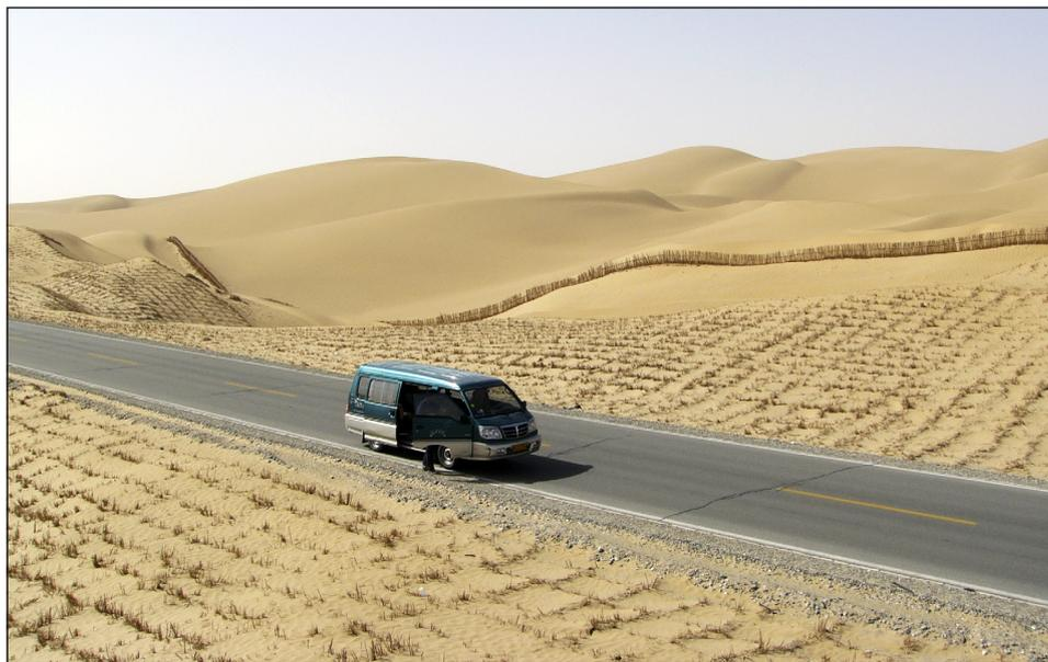
**Abb. 5: Taklamakan-Transitroad mit Schutzverbauungen gegen Sandverwehungen**
