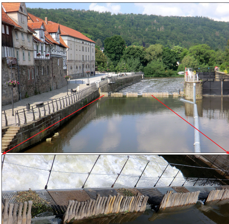
Abb. 15: Das 2015 restaurierte Nadelwehr an der Werrastaustufe in Hann. Münden. Oben: Gesamtansicht des Wehrs einschl. der Schleuse. Unten: Anordnung der Nadeln . Der Abfluss wird durch Wegnehmen oder Hinzufügen einzelner Nadeln reguliert. (Quelle: © Museum Fuldaschifffahrt Kassel, autorisiert)
