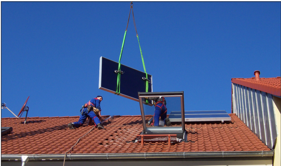
Abb. 1: Solaranlageninstallation auf ein Bestandsgebäude (Symbolbild: © V. Stelzer)
