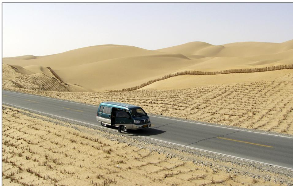
Abb. 5: Taklamakan-Transitroad mit Schutzverbauungen gegen Sandverwehungen
