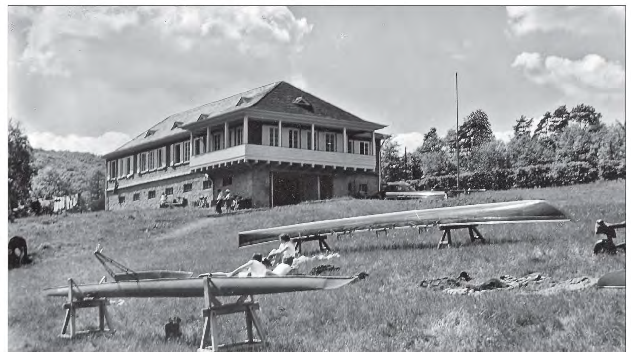
Das Universitätsbootshaus „Hohe Fahrt“ am Edersee (errichtet 1937)
