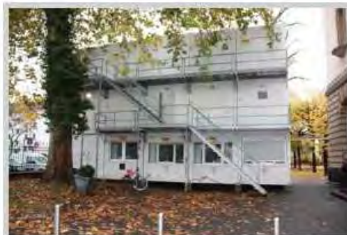
Baucontainer auf dem Stadel-Gelände zur Dürerstraße
