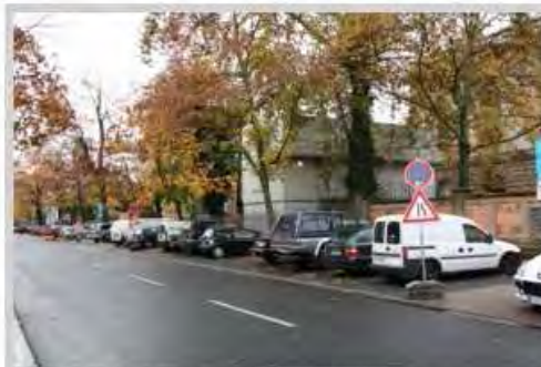
An dieser Stelle wird die halbseitige Sperrung der Dürerstraße eingerichtet
