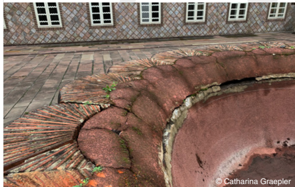
Zerstörung der gesamten Brunnenschale durch Frost und Verwitterung
