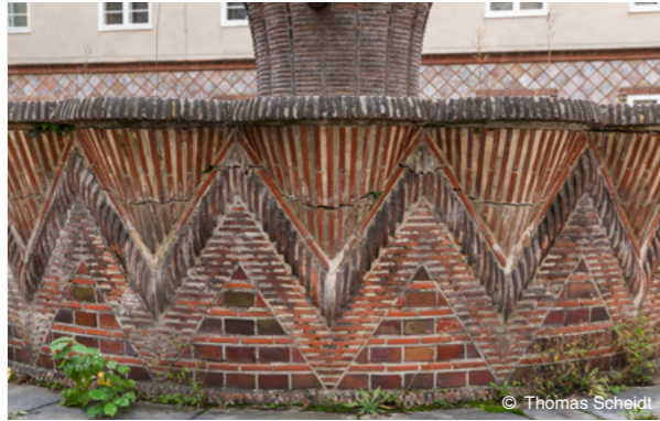
Rissbildung am Brunnenmauerwerk und Sockel
