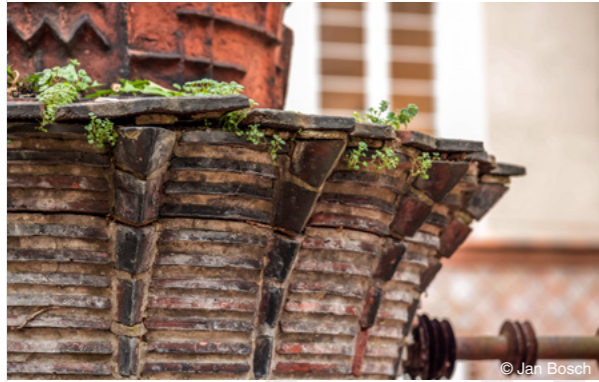
Zahlreiche Schäden an der Verfugung durch Pflanzen
