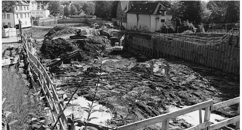
Baugrube der neuen Universitätsbibliothek gen Osten
