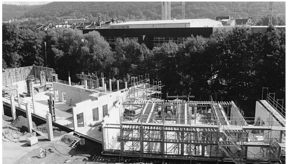
Campus Firmanei: Rohbau des neuen Sprachatlas-Instituts
