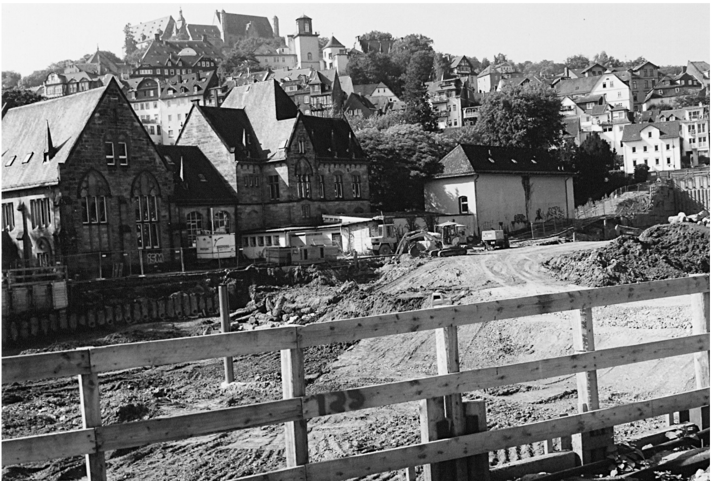
Baugrube der neuen Universitätsbibliothek am Fuße der Marburger Altstadt
