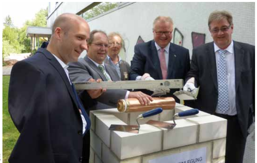
Hand in Hand für den Aufbau eines internationalen Treffpunkts: Uwe Grebe (2. von links), Geschäftsführer des Marburger Studentenwerks, legt den Grundstein zum „Max-Kade-Zentrum“, zusammen mit (von links) Hessens Wissenschaftsstaatssekretär Ingmar Jung, der Marburger Unipräsidentin Katharina Krause, Finanzminister Thomas Schäfer und Marburgs Oberbürgermeister Egon Vaupel.
