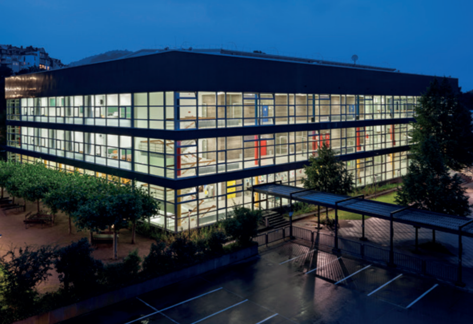
▲ Hörsaalgebäude der Philipps-Universität Marburg
