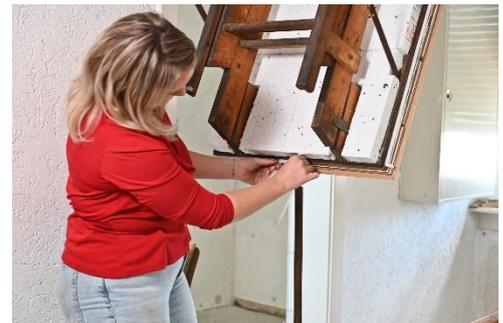
Abbildung 9: Schaumstoffdichtband aufkleben.
