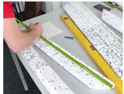
Abbildung 4: Das Profil ist schon einseitig auf Gehrung geschnitten. Nun wird an der Innenkante des "L" die Schnittlinie für die zweite Gehrung markiert.
