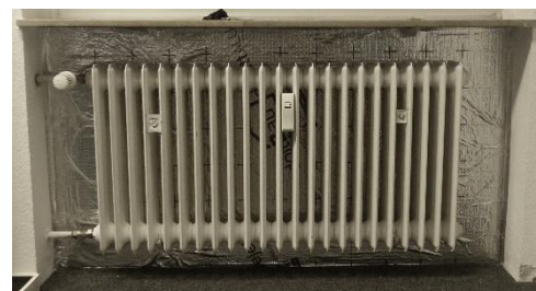
Abbildung 16: Die fertig gedämmte Heizkörpernische: Der Winter kann kommen.
