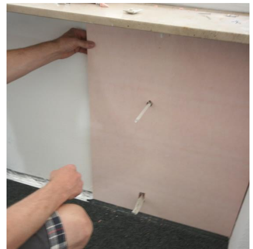
Abbildung 11: Die erste Dämmplatte ist gesetzt.
