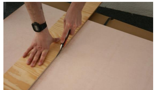
Abbildung 8: Anschneiden einer Resol-Hartschaumplatte.
