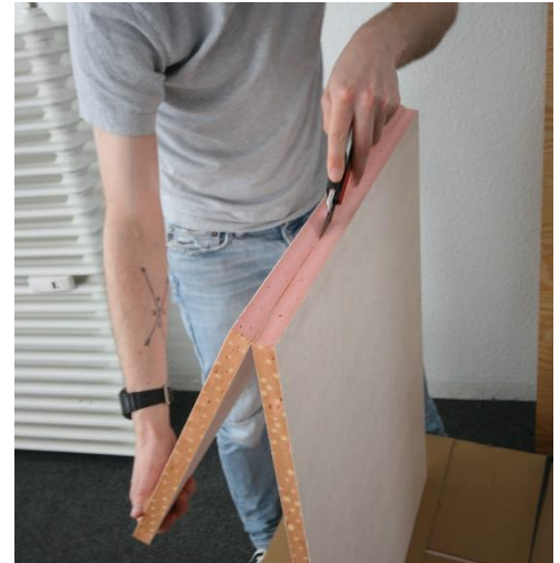
Abbildung 9: Trennen der Vlieskaschierung.
