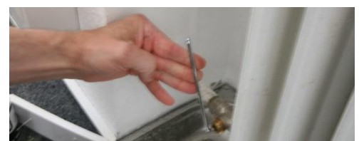
Abbildung 4: Thermostatventil oben und Absperrventil unten (links oben). Schließen des Absperrventils (unten). Abschrauben des Heizkörpers (rechts oben), Wanne ist untergestellt.
