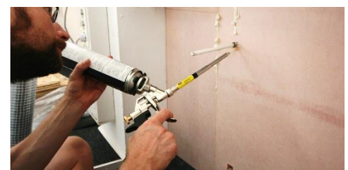
Abbildung 12: Ausschäumen der Fugen.
