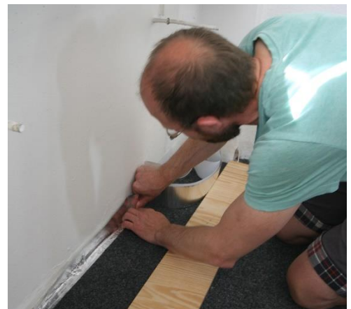
Abbildung 7: Abkleben der Lücke zwischen Estrich und Wand mit diffusionsoffenem Klebeband.
