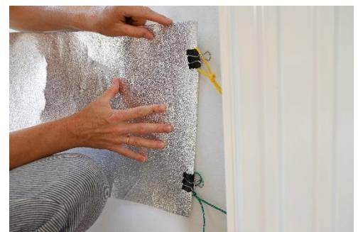
Abbildung 9: Durchziehen der Dämmtapete.
