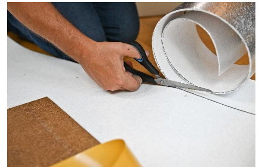
Abbildung 4: Folienstreifen schneiden.
