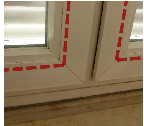
Abbildung 3: Fensterrahmenecke nach dem Säubern. Am besten, du klebst das doppelseitige Klebeband an den markierten Stellen auf.
