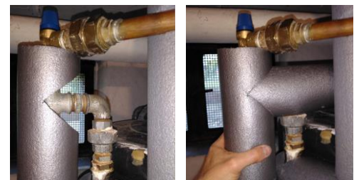
Abbildung 5: So dämmst du einen T-Abzweig perfekt!
