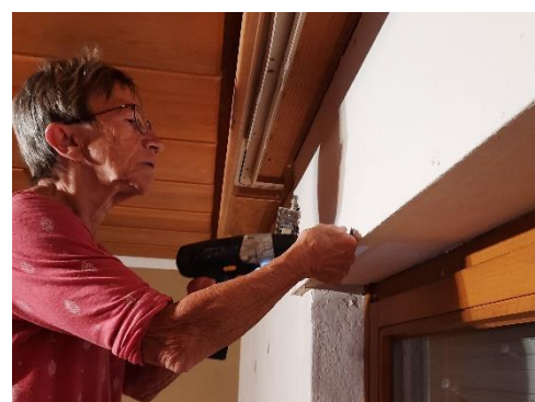
Abbildung 3: Deckel abschrauben
