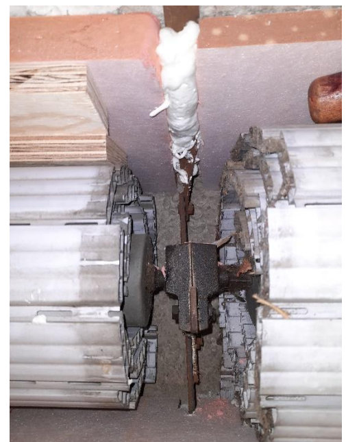
Abbildung 17: Fugen ausschäumen.
