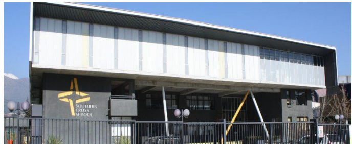
Das Gebäude der Southern Cross Schule
